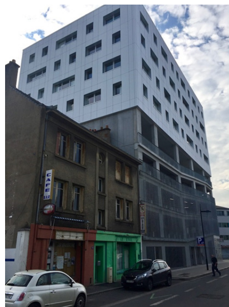
Parking silo avec bureaux, gare sud à Nantes ©Synoptier
