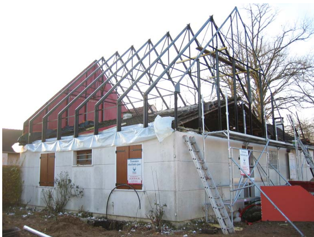
Pose d'une nouvelle charpente avant dépose de l'ancienne
