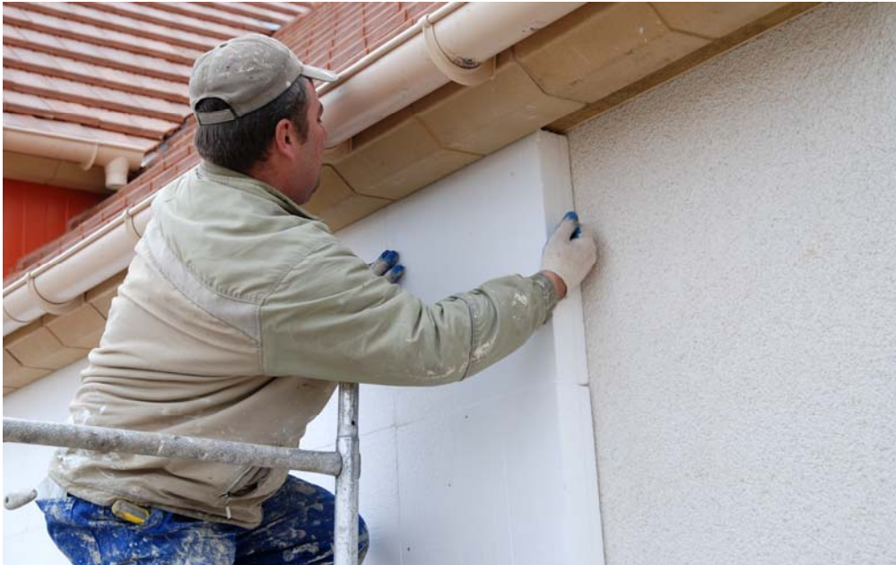
Pose de l'isolation par l'extérieur © Phénix évolution
