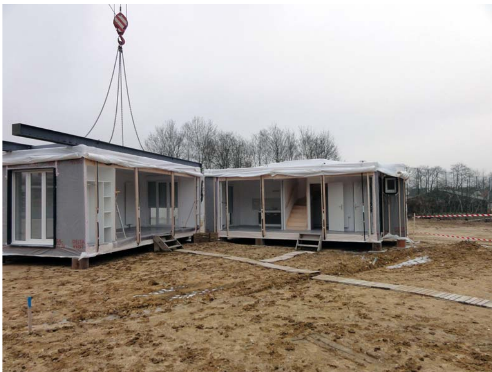
Pose des modules © GC
