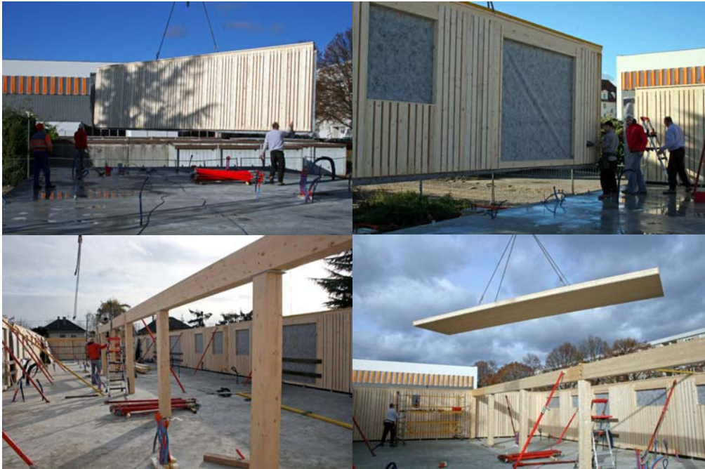
Livraison et pose d'un élément de façade porteur pré-assemblé en atelier © GC
