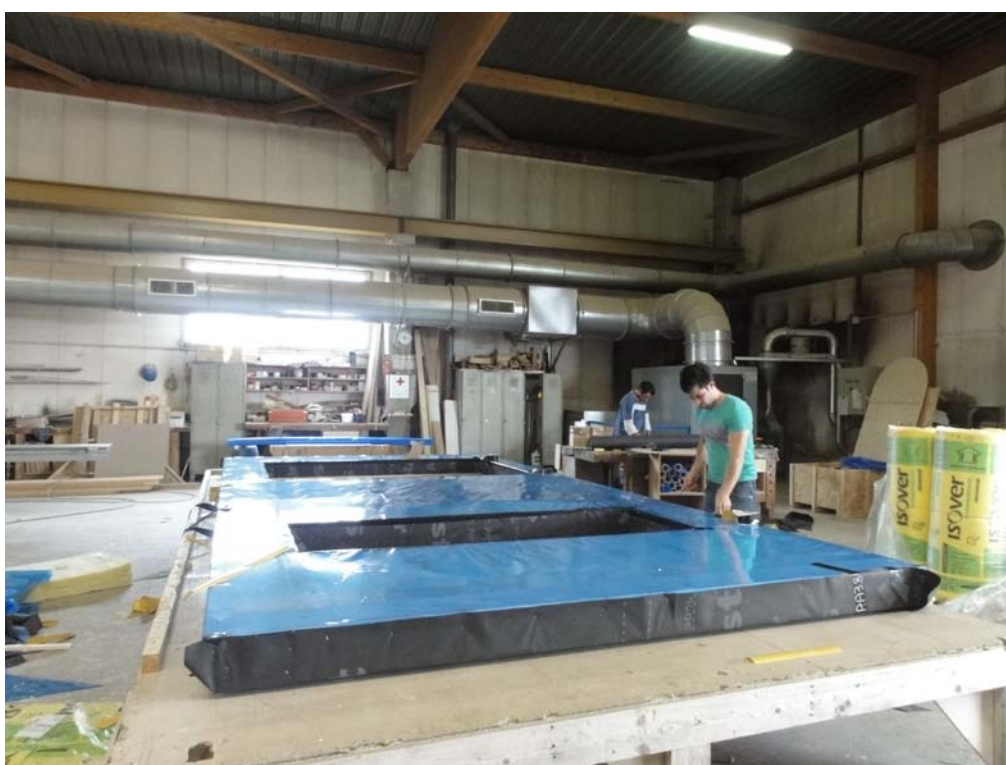
Fabrication des façades en atelier © GC
