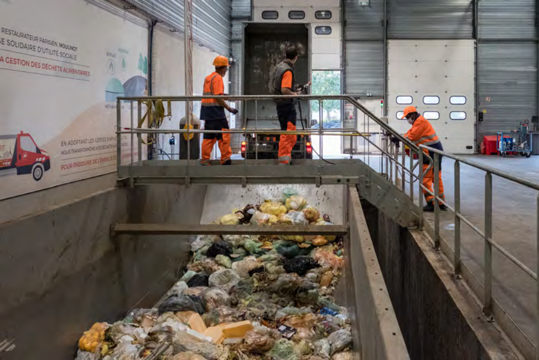
Plateforme de tri et de transformation des biodéchets ou déchets organiques ou déchets alimentaires gérée par la société Moulinot à Stains (93) © Séverine Carreau / L'Institut Paris Region
