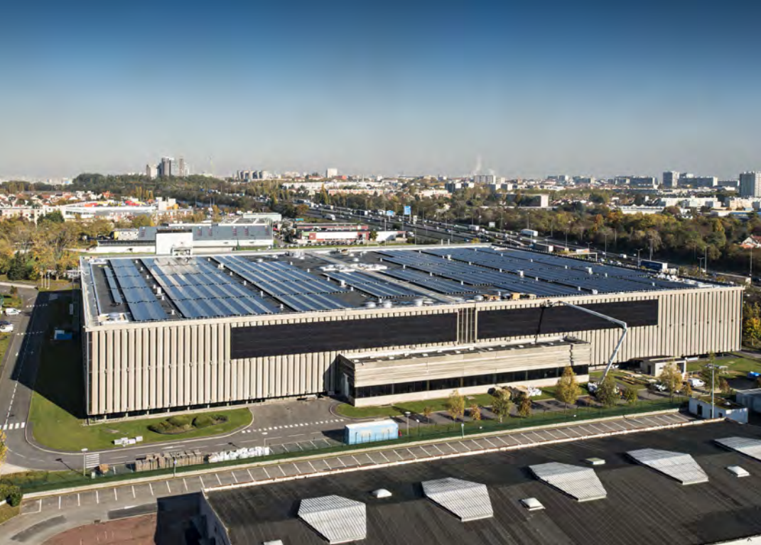
Réservoir de l'usine d'eau potable d'Eau de Paris équipée d'une centrale photovoltaïque à L'Haÿ-les-Roses (94) © Studio Vu
