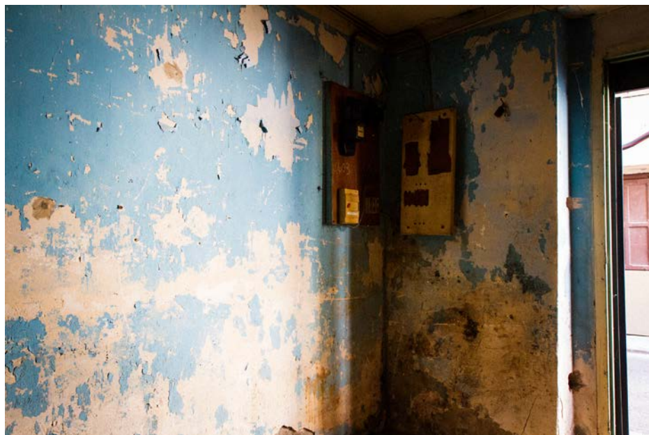
Intérieur d'un appartement en attente de rénovation © Daniel Coutelier | Terra
