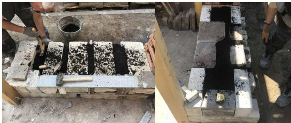
Figure 6. Superposition de deux lits de dalles calcaires. À gauche, une rangée de boutisses en calcaire, à droite, une rangée de panneresses en calcaire avec des dalles en porphyres pour le remplissage au centre © Delphine Lewandowski
