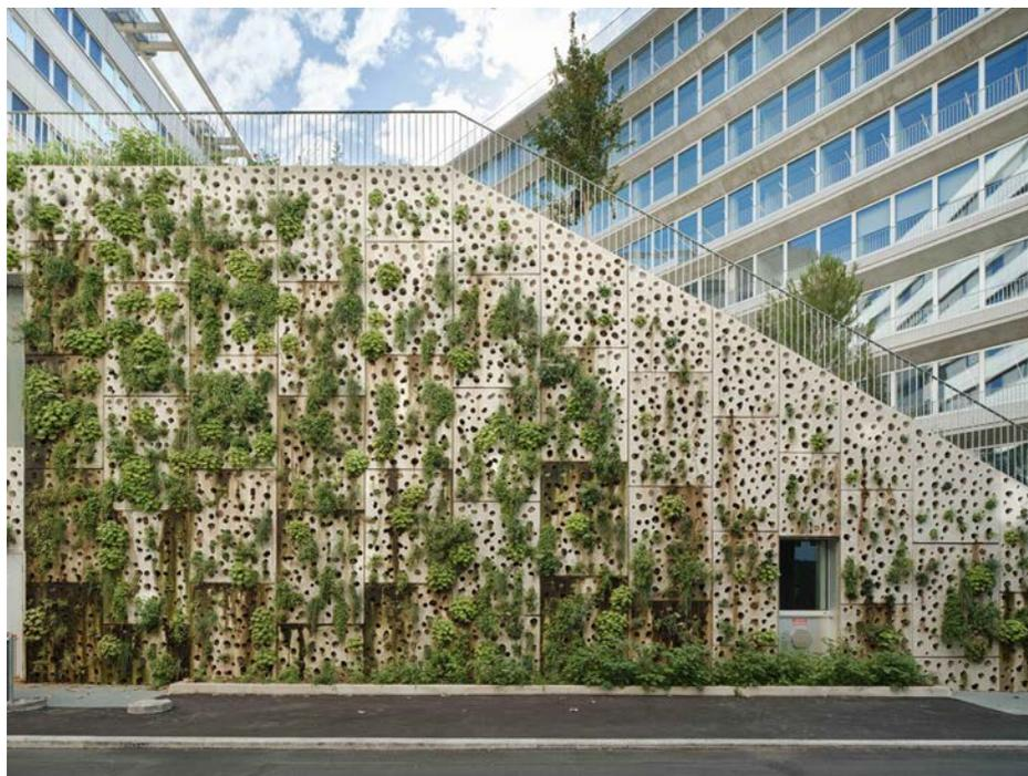
Figure 13. Mur biodiversitaire en panneaux préfabriqués en béton, sur l'enceinte du jardin du siège de l'APHP, 2022 © ChartierDalix, photographie de Takuji Shimmura
