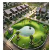
Bassin sec infiltrant à ciel ouvert
