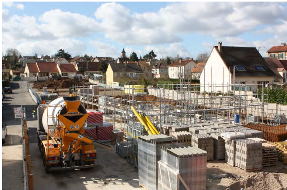
Construction du lotissement de la Ruelle, Villabé, Essonne, 2015 © Commons Wikipédia
