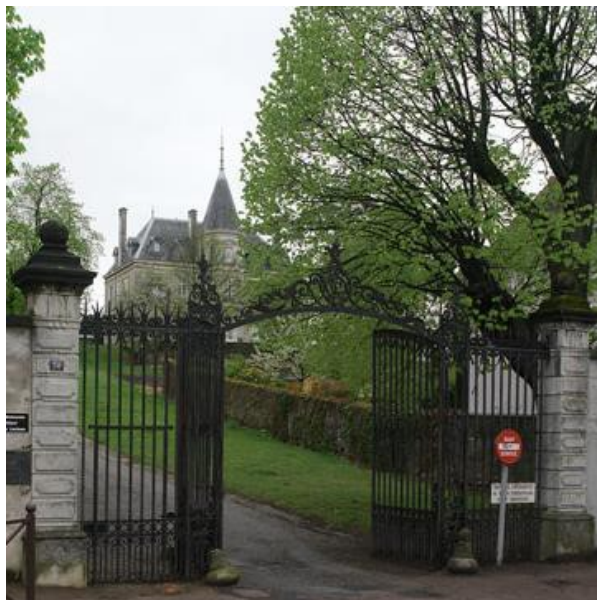
Entrée du Château, depuis l'avenue Alsace Lorraine (Auvergne- Rhône-Alpes)
