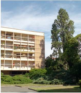
Busca Faubourg XIXème. Immeubles collectifs sur dalle végétalisée ou avec stationnements
