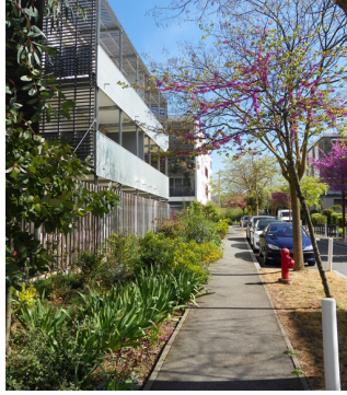
Vidailhan, écoquartier. Immeubles sur voie verte
