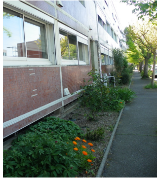
Ancely, grand ensemble années 50. Massif végétal en pied d'immeuble
