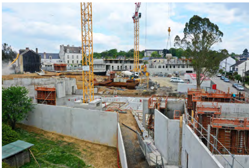
CHÂTEAUBRIANT, îlot des Terrasses, l'opération en chantier © Ville de Châteaubriant
