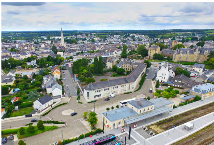
CHÂTEAUBRIANT - Îlot des terrasses avant travaux © Ville de Châteaubriant J. F. Mousseau
