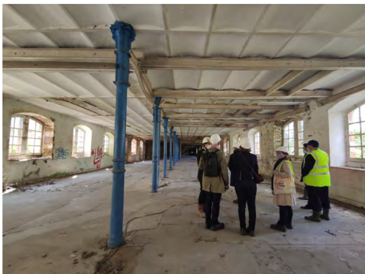
CHATEAURoux - Site Balsan, bâtiment du flockage © Ville de Châteauroux
