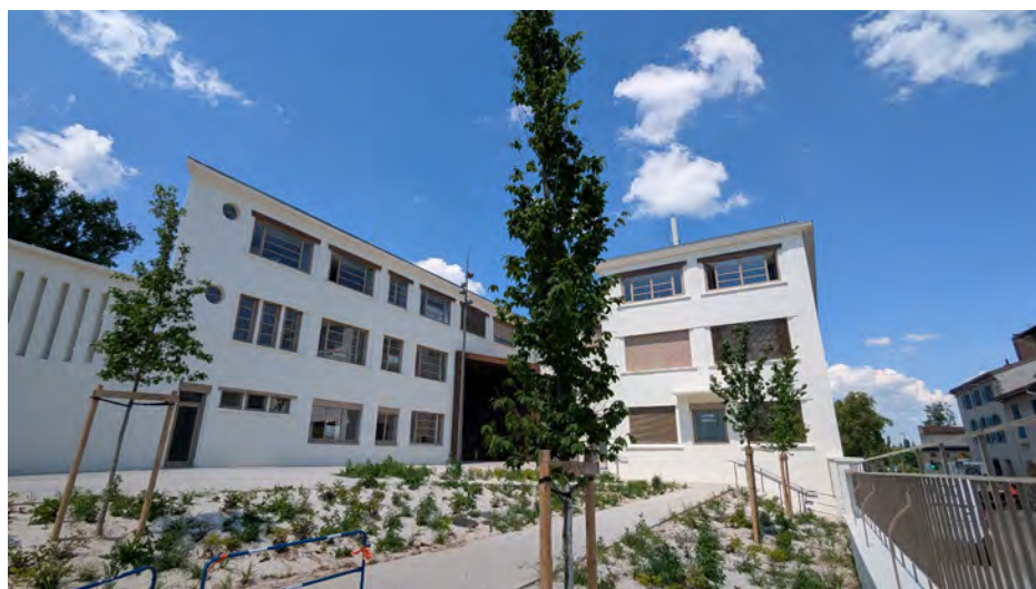
MONTBRISON - Usine Gégé © Ville de Montbrison - Atelier d'Architecture Rivat - Croisée d'archi - Archipente [MOE]
