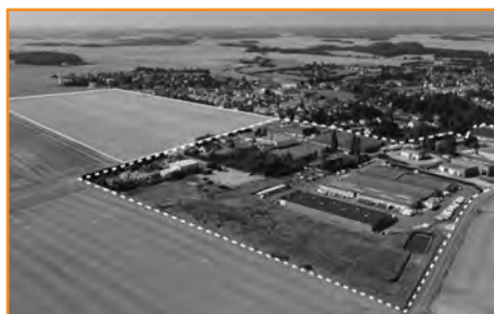
Extension de ZAE existante
