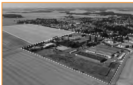
Extension de ZAE existante
