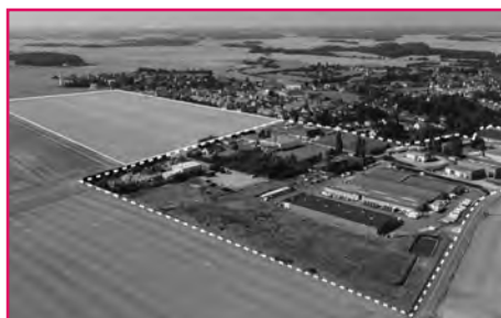
Extension de ZAE existante
