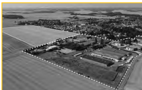
Extension de ZAE existante
