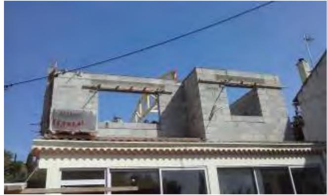
M. a donc fait le choix avec son architecte de la réalisation d'une extension classique en parpaing avec réfection totale de la charpente et de la toiture. Au départ, le projet incluait la réutilisation de la structure de la toiture, mais au final cela s'est révélé trop difficile à mettre en œuvre. La toiture a donc été refaite entièrement, ce choix a été réalisé avec l'architecte, tout en restant au plus près du montant prévu initialement.
