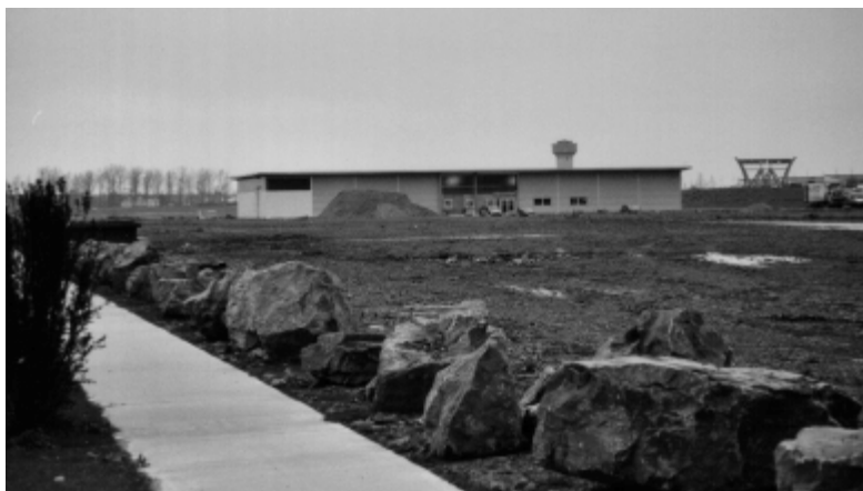
Les débuts de la zone d'activités Normandial sur l'ancien site SMN, cliché S. Valognes, 2001.
