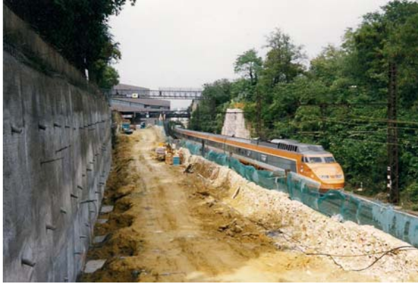
Le plus gros chantier de la ligne 1 ; passage de la ligne 1 au même niveau que la ligne SNCF, les voitures passent au dessus sur un viaduc.
