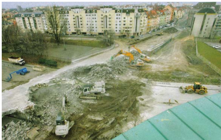
À l'emplacement du viaduc Churchill : de « grands espaces à reconquérir » (SM, n°172, avril 2006).
