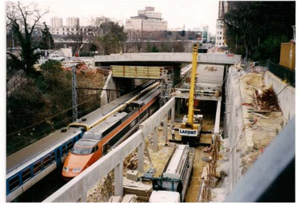
Réalisation du viaduc et du passage piéton entre le Lycée Joffre et l'Esplanade (Février 1999, M.Bozzola).
