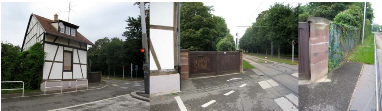
La rue du Grand-Couronné, au croisement avec la plate-forme du tramway : un portail déplacé, un muret coupé, un passage piéton, une maison munie de doubles-vitrages.
