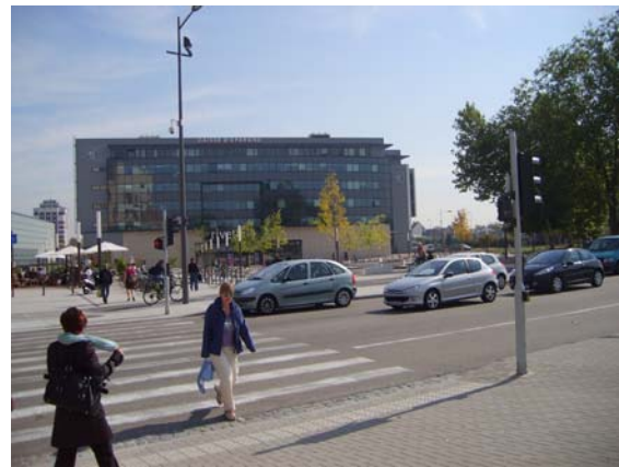
Centre commercial Rives Etoile, situé entre la ligne A et la ligne E (vue depuis la station de tram Place de l'Etoile de la ligne A)(Christine Blanc, 28 septembre 2009)
