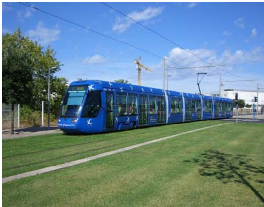
Engazonnement des voies de tram à Montpellier à Occitanie (M.Bozzola).
