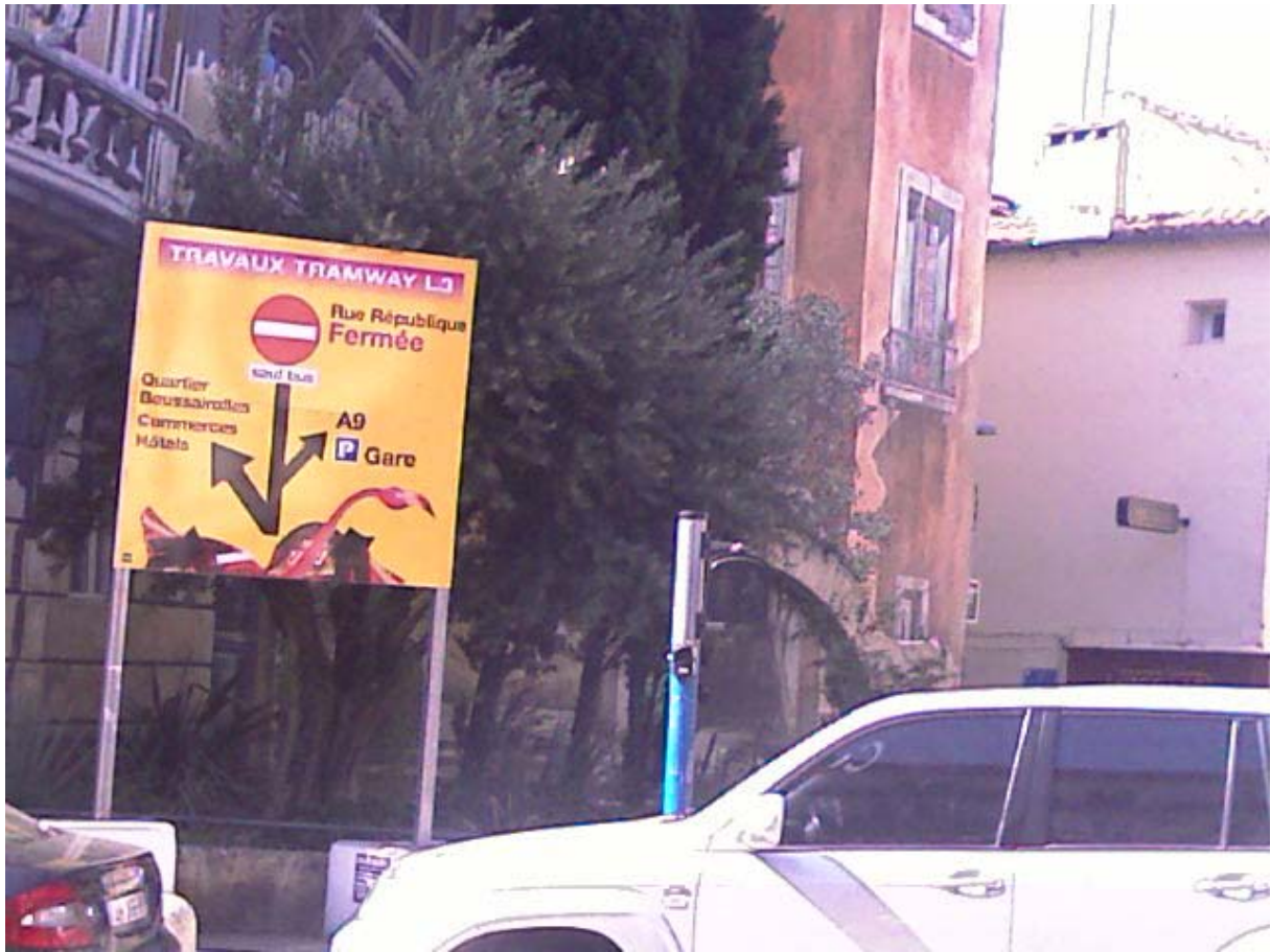
Figure 10 : Panneau de signalisation de travaux pour le tramway - juillet 2010
