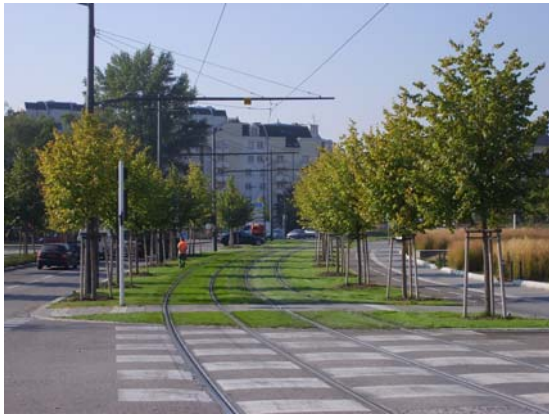
Engazonnement des voies de tram à Strasbourg à proximité de la station Pont Churchill (Christine Blanc, 28 septembre 2010)
