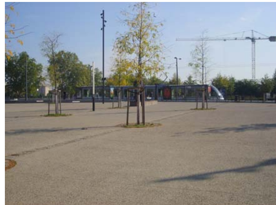
Station de tram Pont Churchill ligne E (Pont à niveau remplaçant l'ancien viaduc Churchill)
