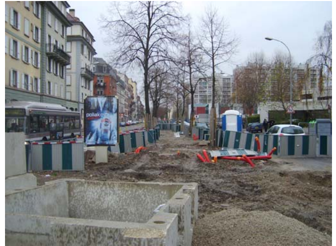
Travaux à l'Esplanade (Christine Blanc, novembre 2009)
