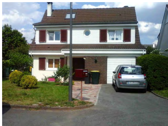
Construction, 25 rue Sainte Beuve à Meyzieu
