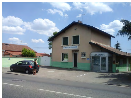
Clinique vétérinaire, 56 avenue de Verdun à Meyzieu Vaulx-en-Velin
