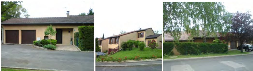
Artisan électricien, 15 chemin des Aulnes à Dardilly ; pavillons mitoyens R+1 et plain-pieds
