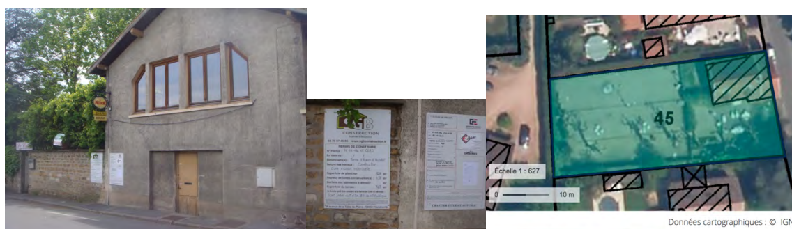
Bar-restaurant (à vendre), 72 avenue Pasteur à Saint-Didier-au-Mont-d'Or : vues de la maison, des panneaux de permis d'aménager et de construire ; vue de la parcelle avant cessation de l'activité (Géoportail, 2017)
