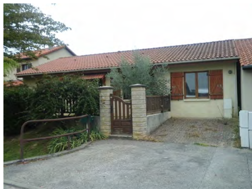
Travaux de bureau, 4 chemin des Alouettes à Rillieux-la-Pape
