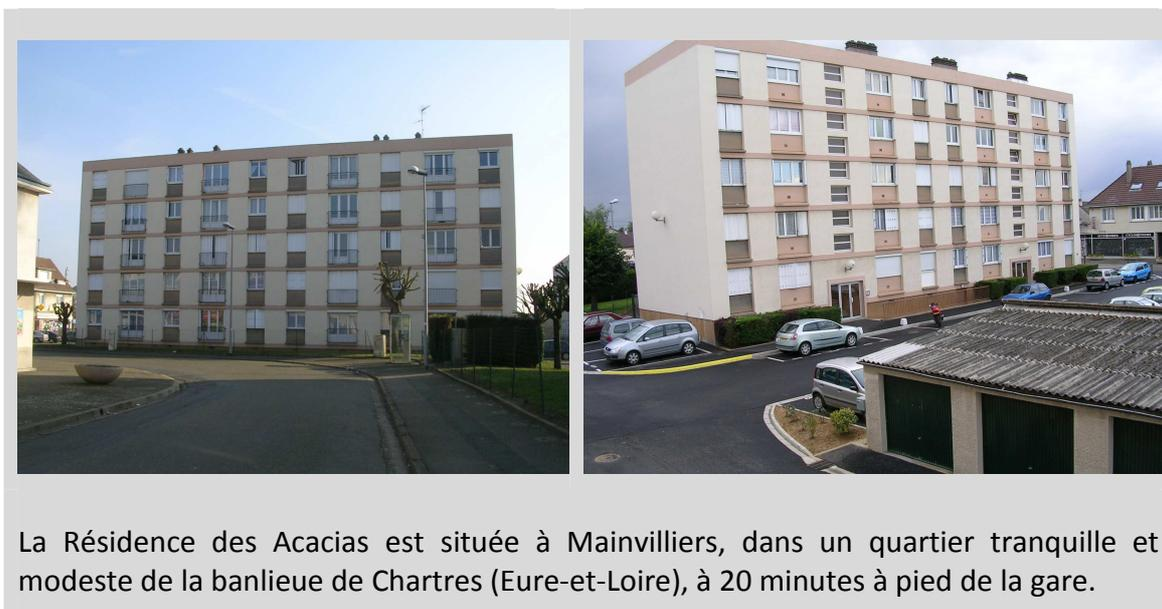
Elle se compose de 3 bâtiments R+4, sans ascenseur, construits en 1962. Les logements sont chauffés par un chauffage collectif au sol alimenté au gaz. Le renouvellement d'air dans les appartements s'effectue par un système de ventilation naturelle par conduit shunts dans les pièces humides et entrée d'air en cuisine.
