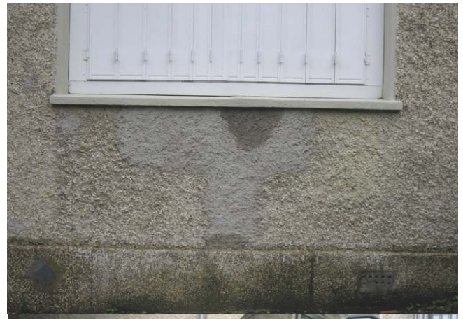
Figure 49. Un des principaux points d'achoppements du projet a été la réfection partielle des enduits « mignonette » imposée par l'ABF et subie à la fois par l'architecte (qui aurait préféré une réfection totale et la pose d'un isolant extérieur) et par les habitants.
