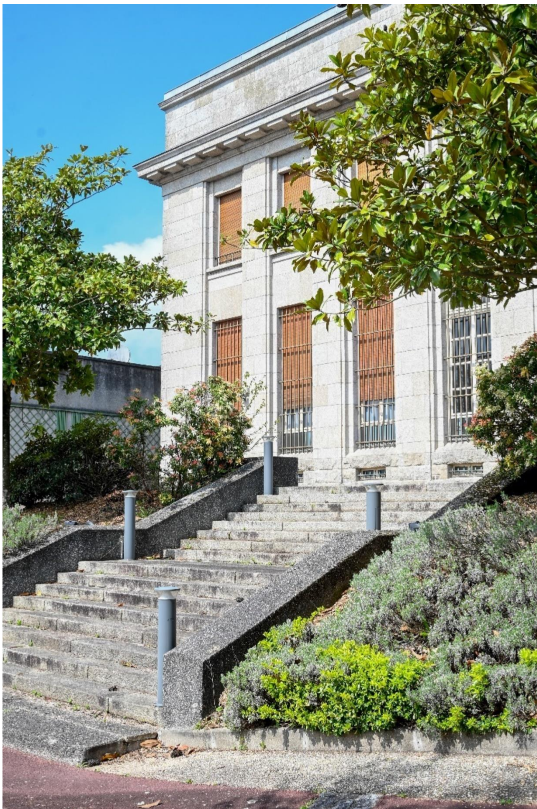
Photo extérieure de la Banque de France
