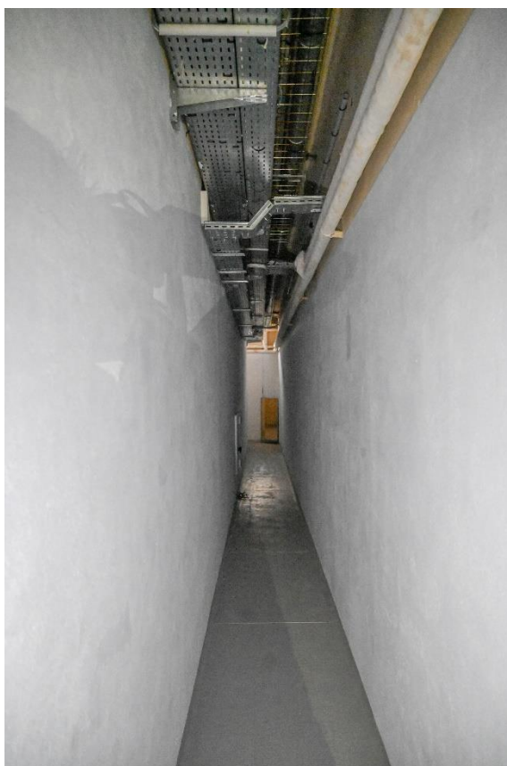
Photo du chemin de ronde au sous-sol
