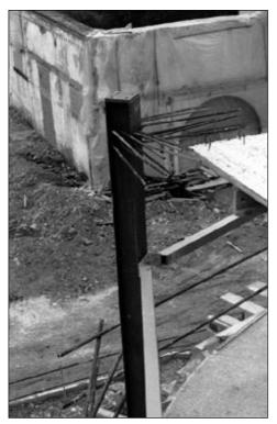
en rive de dalle. La mise en oeuvre est on ne peut plus lente et suppose un étaiement en rive de dalle.
