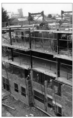
cette solution entraîne une mise en place décalée par rapport au charpentier et rallonge les délais de montage de la structure. De plus, le charpentier ne peut bénéficier de la grue de chantier.
