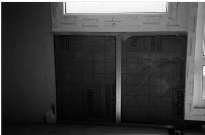
ge et de supprimer ainsi le vissage. Ce premier essai a montré qu'il fallait persévérer dans la recherche d'un profil mieux adapté. Un autre essai a porté sur un cadre prototype destiné à traiter le problème de la mise en place d'Optima autour des menuiseries PVC.
