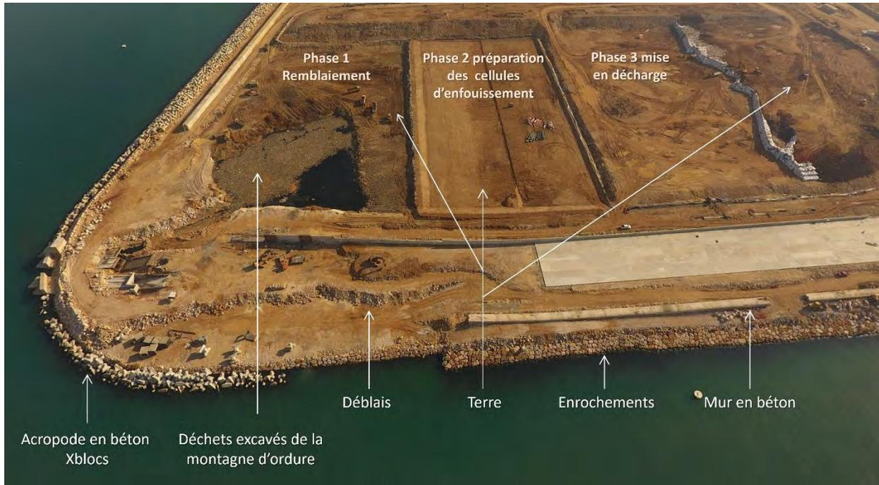
**Figure 6** : Les différents matériaux utilisés dans la construction des remblais à Jdeydeh. Source : KCC, 28 novembre 2018, entretien 2021. Réalisation personnelle.
