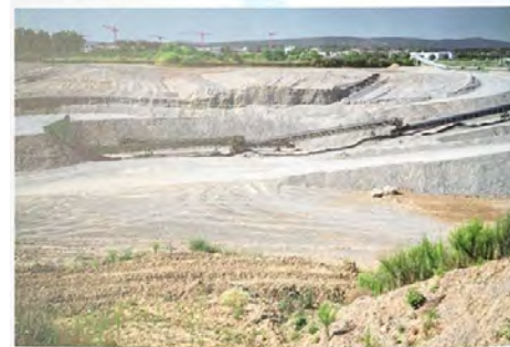
Transformer le paysage pour reprendre le site. Au fond de l'axe de la carrière qui se transforme en parc, les grues du chantier Bâle PR d'Alstom, CH illustrent le site à dynamique urbaine du secteur
