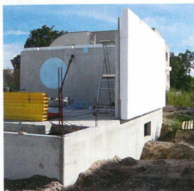
est très particulier puisque des nappes chauffantes sont intégrées, en usine également, dans la partie basse du voile béton. « Un système de paroi chaude qui nous permet avec 3 kW de puissance installée, de chauffer une maison de 100m<sup>2</sup>. »
