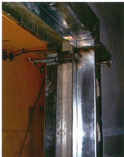
**GTM Bâtiment.** La réalisation du traditionnel coffrage en bois, utilisé pour mettre en place une huisserie dans des murs maçonnés ou banchés existants, nécessite une bonne dose de savoir-faire pour, au final, un usage unique et surtout un résultat pas toujours satisfaisant. Un constat à l'origine d'un nouveau coffrage en acier galvanisé qu'il est possible de réemployer quasiment à l'infini: composé de deux moitiés en U, as-
