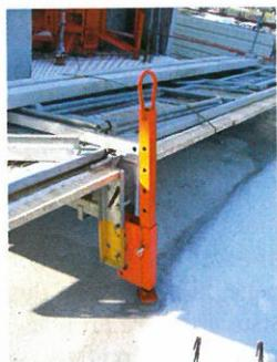
réalisation d'un platelage sur mesure qui n'était pas réutilisable... aucune solution n'était vraiment satisfaisante et la sécurité pas toujours assurée. « Nous avons donc modifié les consoles pignons qui servent traditionnellement à poser les banches en rajoutant simplement, à l'arrière, un pied réglable de 55 cm à 1,60 m. La partie avant de la console reste accrochée à la façade par le système classique d'attaches volantes. » Ce procédé nécessite toutefois le démontage d'une partie de
