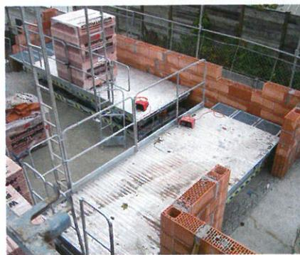
côté, donc de porter sa longueur à 6 m. Des éléments d'extension de 30 cm de profondeur et 1 m de large peuvent se clipser sur l'avant pour épouser des décrochés de façades.
