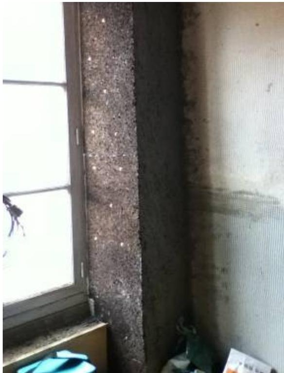
Liège (0,04 W/mK) fixé sur de la pierre (1,5 W/mK) par vis acier (50 W/mK) traitée cuivre (380 W/mK)
