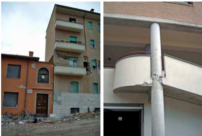
Exemple de martèlement / Exemple de colonnes courtes. Séisme de L'Aquila 2009.
