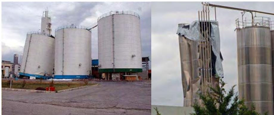
Dommages aux réservoirs. a) séisme en Turquie (1999); b) séisme de L'Aquila.
