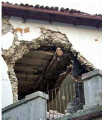
Exemple d'irrégularité locale. Collapse hors du plan de la maçonnerie due à l'action horizontale de la poutre en bois. Séisme de L'Aquila 2009.
