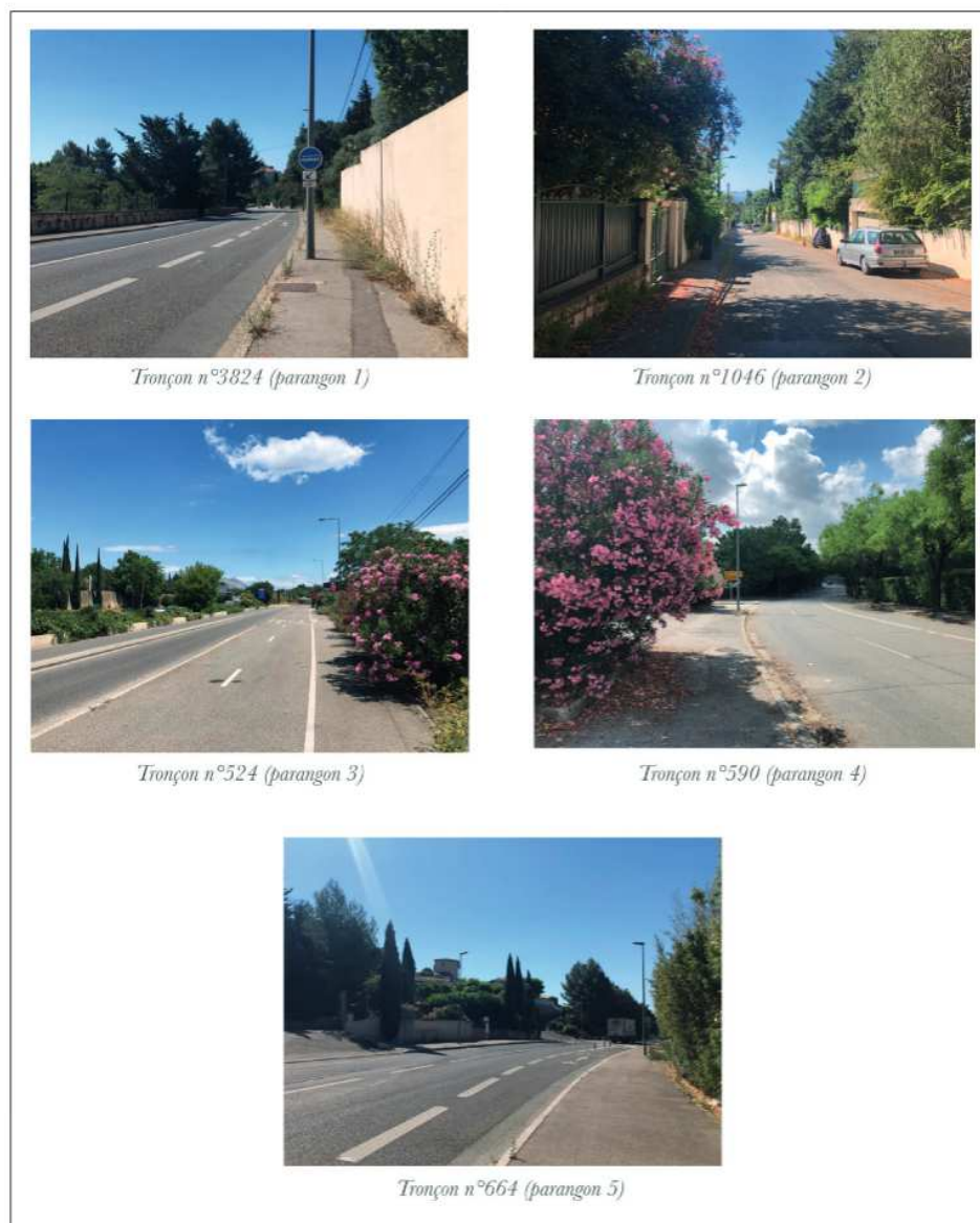
Fig. 14. Photographies des tronçons les plus représentatifs de la situation de boulevards périurbains et des voies de desserte publiques
