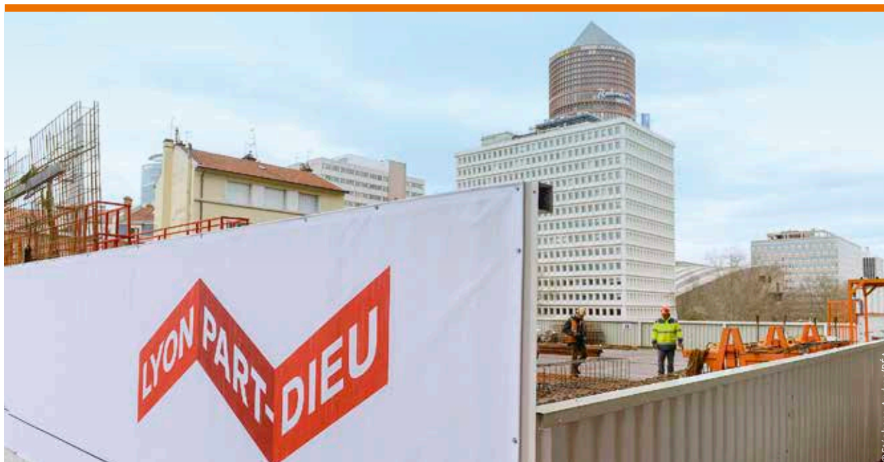
Chantier de construction de la tour Incity
