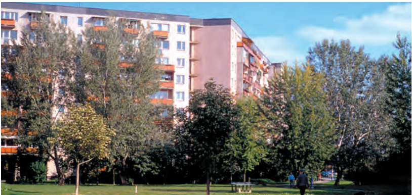
Un grand ensemble typique des années 1970 (district de Goclaw), pour lequel on souhaite aménager différemment les espaces extérieurs et permettre plus d'appropriation.
