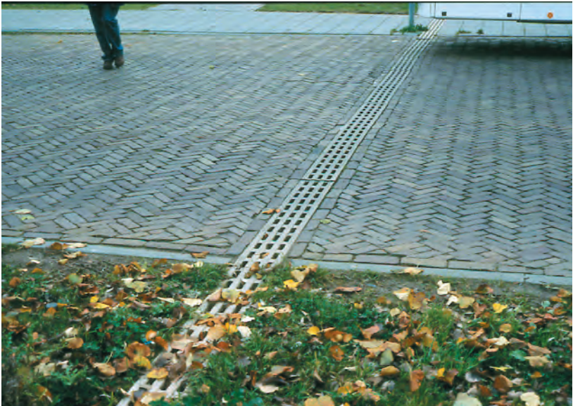
Détail d'un passage sous chaussée pour petite faune, facilitant la circulation entre les jardins privés d'un lotissement et le réseau des canaux.
