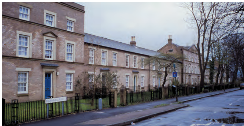
Logement traditionnel en bande (réhabilité).
