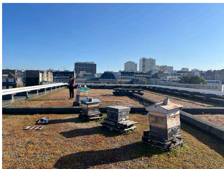
Immeuble Les Nouvelles Manufactures, Mobilier National
